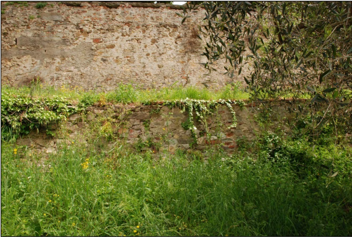
Figura 42. Area potenziale di Fiesole (Firenze): muretti non idonei per il monitoraggio della fauna.
