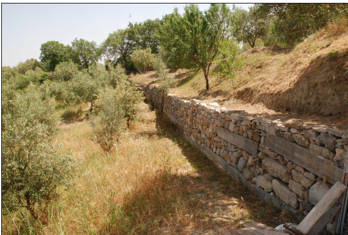
Figura 44. Oliveto coltivato e muretto a secco oggetto di recente ristrutturazione (tipologia di muretto non idoneo).
